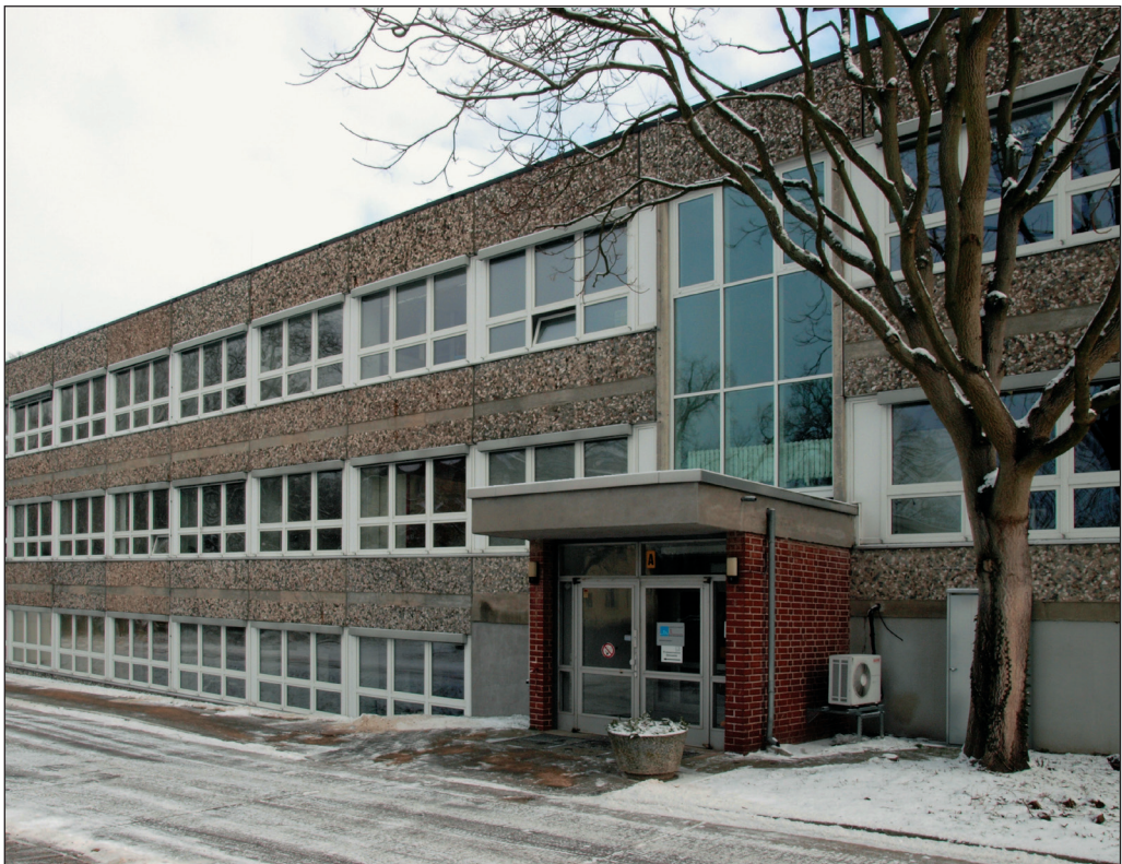
Abb. 27: Gebäude des Fachbereichs Landwirtschaftliche Chemie des Landeslabors in Brandenburg
