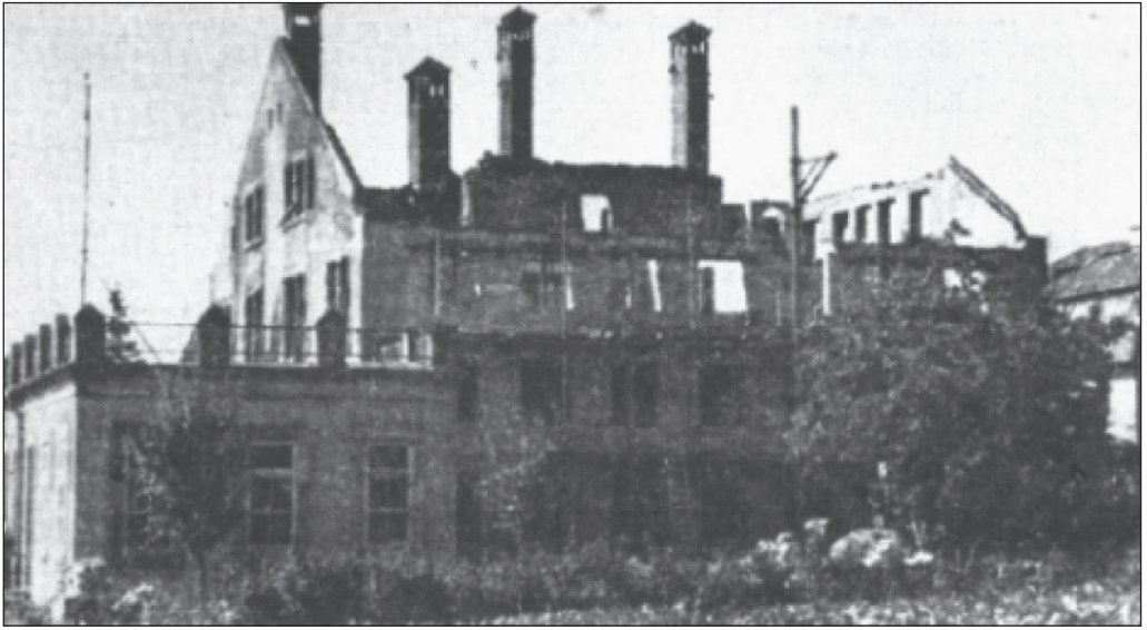
Abb. 11: Das zerstörte Gebäude der LUFA in Kassel-Harleshausen
